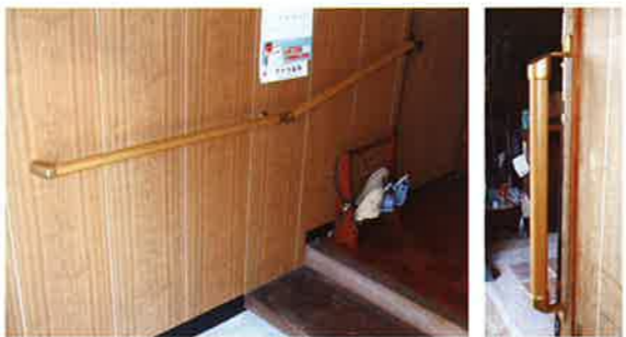
住宅改修で手すりを取付他に簡易手すり、ポータブルトイレを設置
