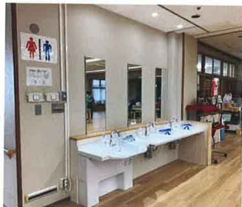
③ 共用部のトイレ改修
