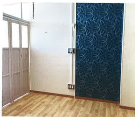
② 改修後の居室
